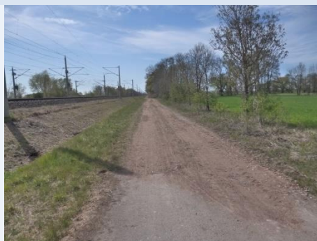
NA 03 Richtung Nahrstedt: teils grob geschottert, teils wassergebunden Ausbau notwendig (2,2 km)
