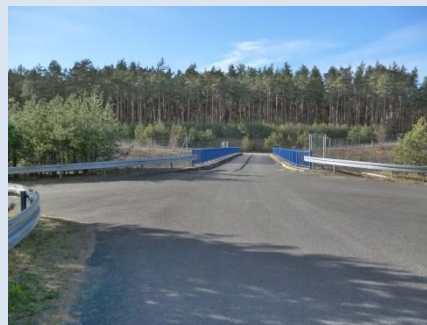
Brücke über die B188 bei Börjitz
